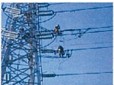
架線作業（長さ調整）の様子
