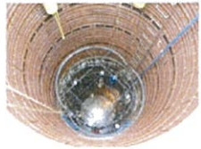
基礎基礎の内部
