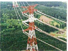
工事完成の様子 2
