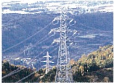
工事完成の様子 3
