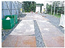
敷地による仮設道路
