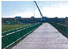
大型機材用の仮設道路
