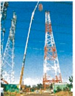
トラッククレーンによる組み立
