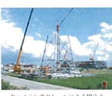
クライミングクレーンによる組み立
